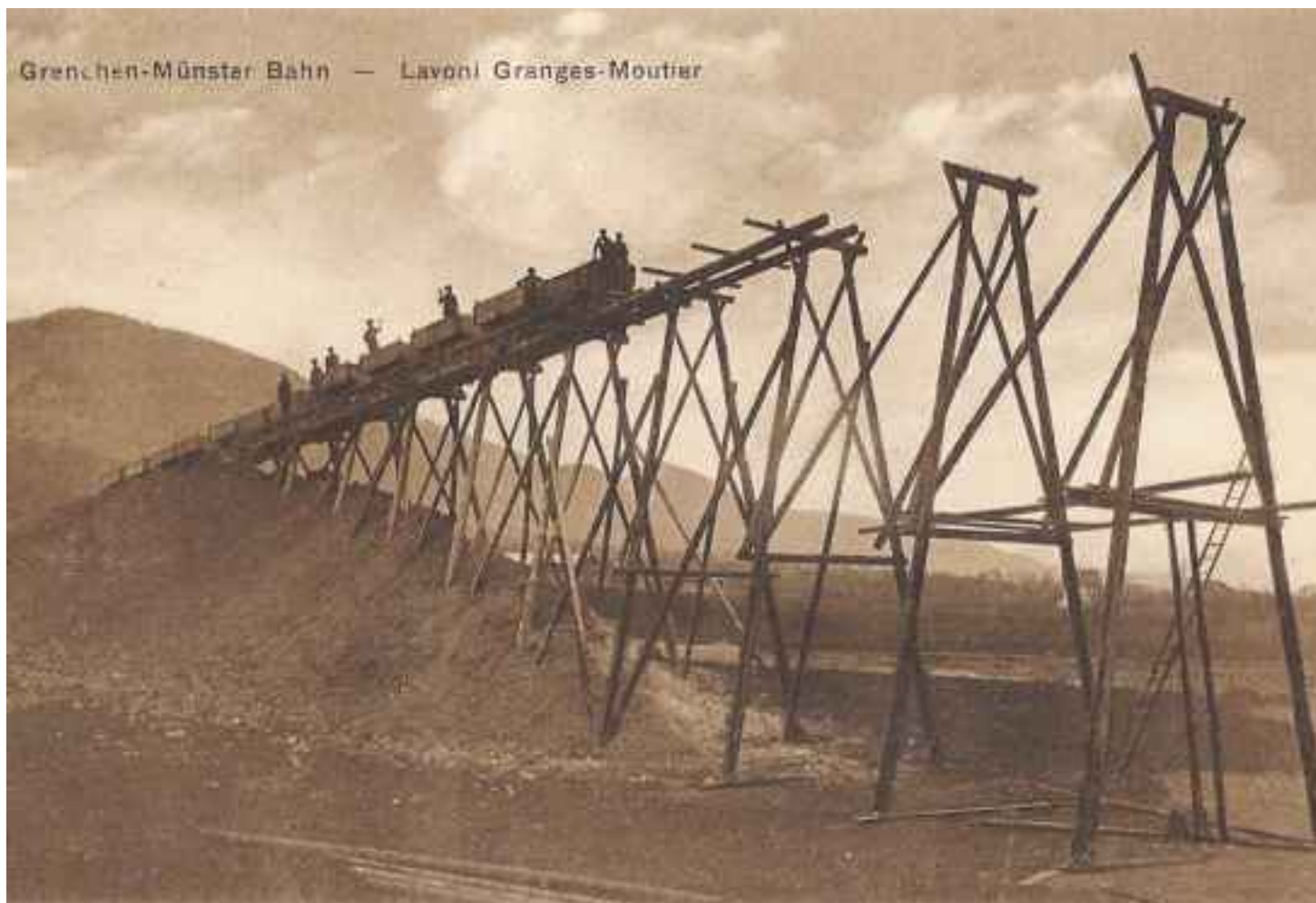
Der Oberdorfviadukt im Bau. Er entstand gleichzeitig wie der Grenchenbergtunnel.
